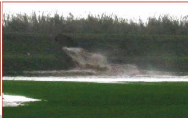
08.45 CET La venuta ha scavato una voragine nell'argine
